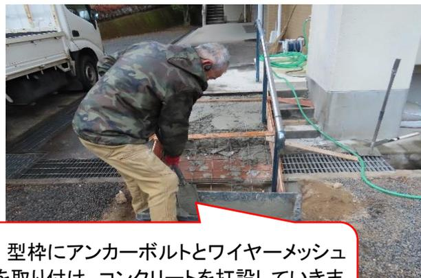
型枠にアンカーボルトとワイヤーメッシュを取り付け、コンクリートを打設していきます。コテで平らに均一にしています。
